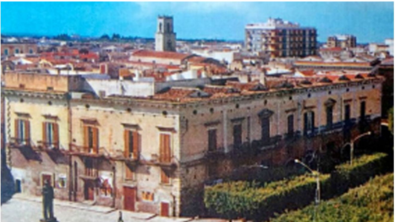
Facc. laterale su L.go Plebiscito e fronte principale su C.so Mazzini
