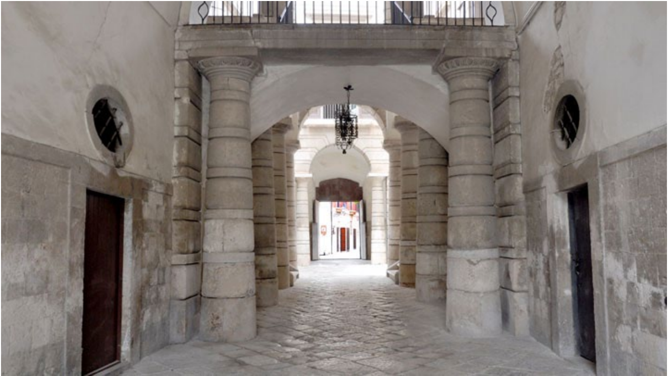
Palazzo Gioia – Vano portone e Atrio centrale entrando dall'ingresso di C.so Mazzini
